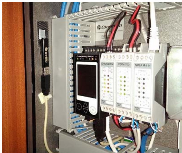
Fig. 9 USB:stickans placering i huvudskåpet
