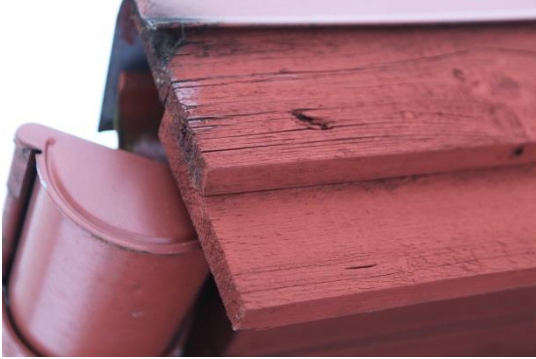
Figur 14. Ändrä är speciellt svårt att skydda eftersom vattenupptaget sker så snabbt. På utsatta ställen krävs extra underhåll.
