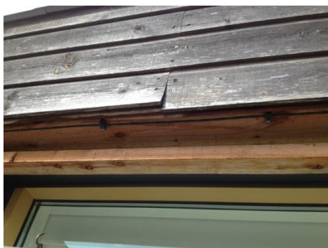
Figur3 Tunnare dimensioner är ofta mer benägna att slå sig och orsaka formfel.
