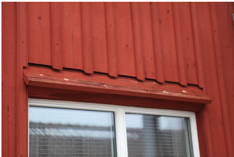
Figur 10. Slamfärg fäster dåligt på kådrika kvistar. Dessutom är det inte lämpligt att behandla liggande panel med denna färgtyp.
