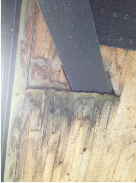
Figur 6. Att friställa virkesytor med ändträ gör konstruktionen extra fukt känslig.
