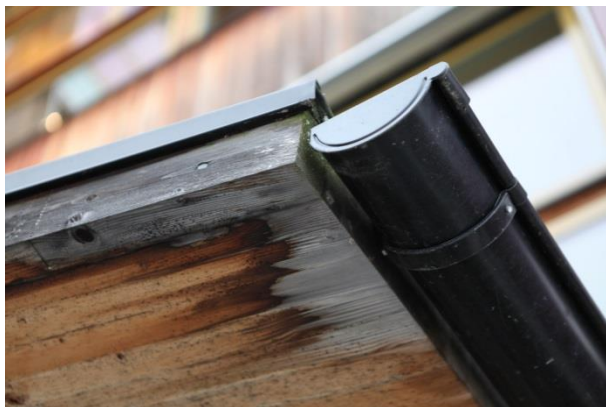
Figur 8. Otillräckligt skyddat ändträ
