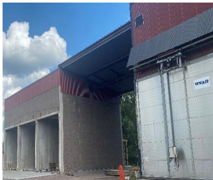
Figur 9. Torkarna torkar ned virket till en lägre fuktkvot.
