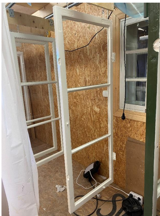
Figur 6: Fönster som undergår renovering och torkas i väntan på kittning. (Fotografi taget av Rebecca Bondesson)
