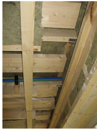
Att arbeta i undertaket med kompletterande gles och isolering har varit mycket tidsödande och besvärligt eftersom det innebär arbetsmoment över huvudet.
