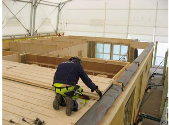
När väggmontaget är klart påbörjas bjälklagsmontaget. Fästpunkterna för bjälklagslyftet har många gånger varit för långt isär. Det har gett stora dragkrafter i lyftbanden. En av anledningarna till detta har varit att taket på väderskyddet inte varit så högt över montageplatsen.
