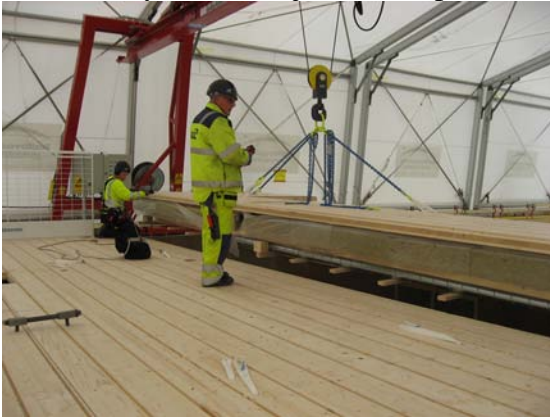
När väggmontaget är klart påbörjas bjälklagsmontaget. Fästpunkterna för bjälklagslyftet har många gånger varit för långt isär. Det har gett stora dragkrafter i lyftbanden. En av anledningarna till detta har varit att taket på väderskyddet inte varit så högt över montageplatsen.
