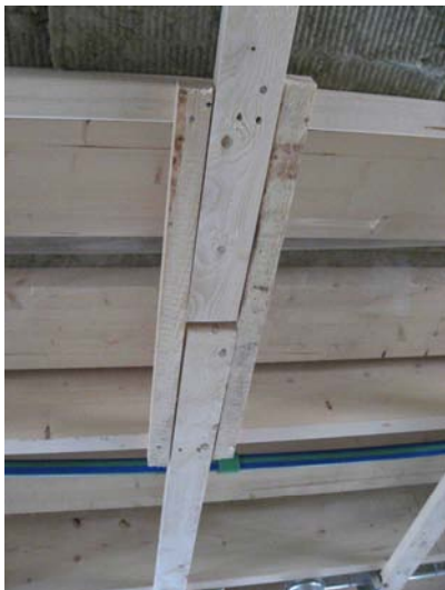
Att arbeta i undertaket med kompletterande gles och isolering har varit mycket tidsödande och besvärligt eftersom det innebär arbetsmoment över huvudet.
