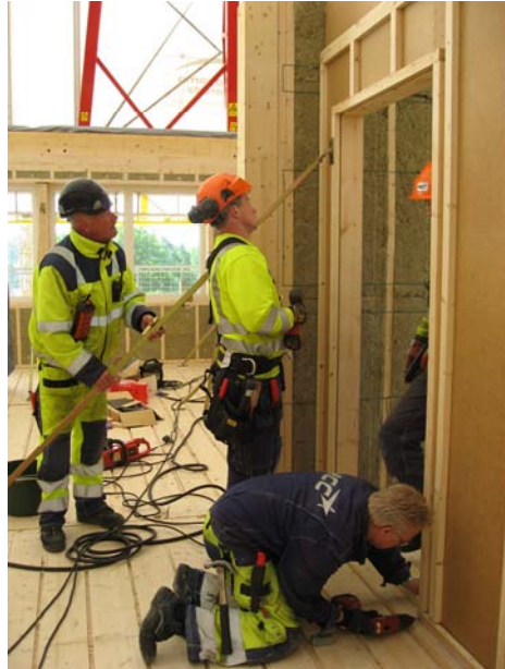
Styrlist och lejd fästs ihop samtidigt som väggelementet placeras vertikalt.
