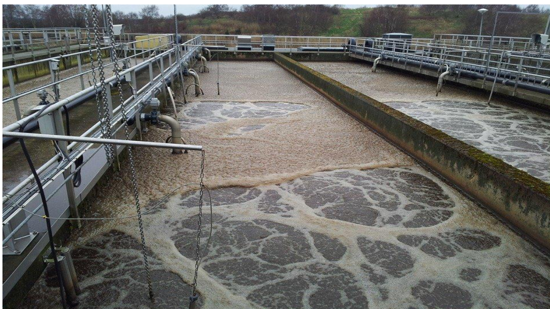
Figur 1.1 Luftningsdel i aktivslamsteg på Kalmar avloppsreningsverk. Foto: Ida Angeland
